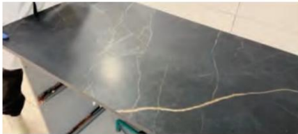
Collocare la lastra sopra il mobile. Coloque la encimera sobre los gabinetes.
