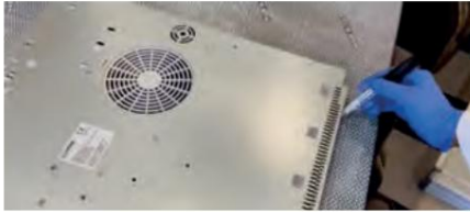
Segnare il perimetro del sistema sul retro del top cucina. Marque el perímetro del sistema en la parte posterior de la encimera.
