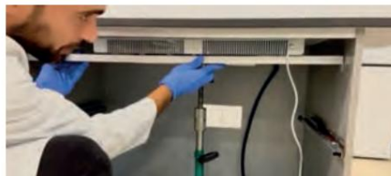
Sistemare e avvitare le barre metalliche sotto al sistema. Coloque y atornille las barras de metal debajo del sistema.
